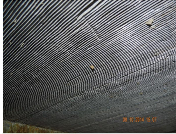
Bild 4: Ansicht Rückkühler (Ausschnitt) von unten nach der Entkalkung
