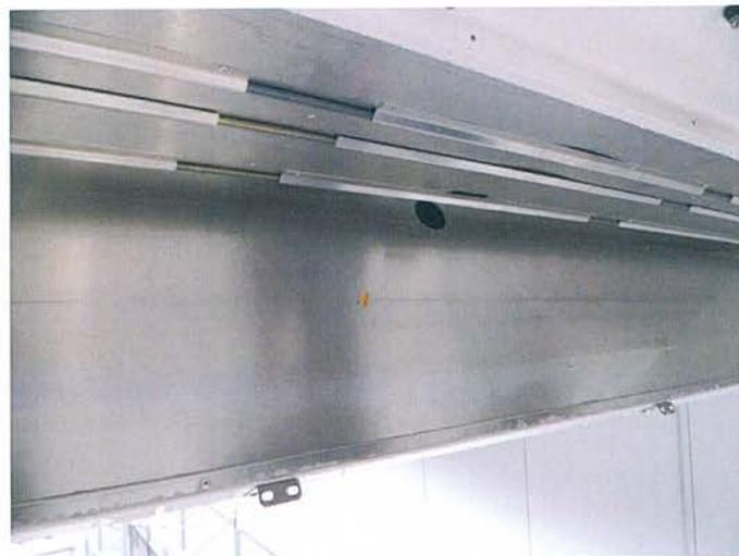
**Foto 2:** Verdampfer – untere Kondensatwanne, nach der Reinigung
