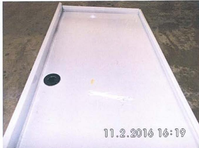
**Foto 5:** Verdampfer – untere Kondensatwanne, nach der Reinigung
