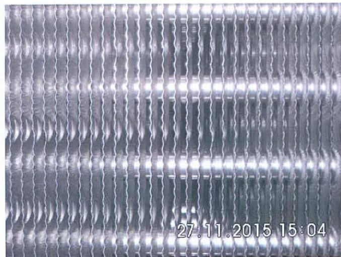
**Foto 6:** Verdampfer – Wärmeübertrager anströmseitig, nach der Reinigung
