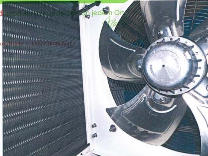
**Foto 1:** Verdampfer – Wärmeübertrager abströmseitig und Ventilator, nach der Reinigung
