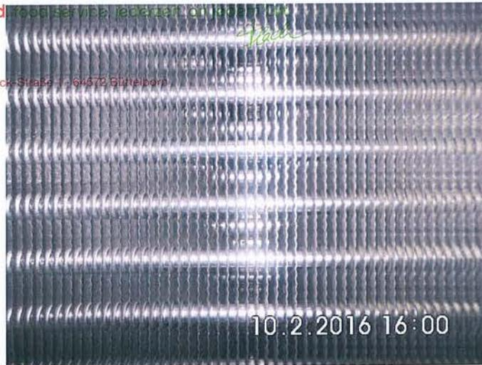
**Foto 4:** Verdampfer – Wärmeübertrager anströmseitig, nach der Reinigung
