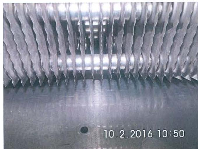
**Foto 3:** Verdampfer – Wärmeübertrager anströmseitig und obere Kondensatwanne, nach der Reinigung
