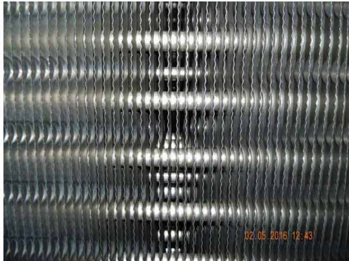
Foto 1: Verdampfer 4 – Kühllager 4°C - nach der Hygiene-Reinigung
