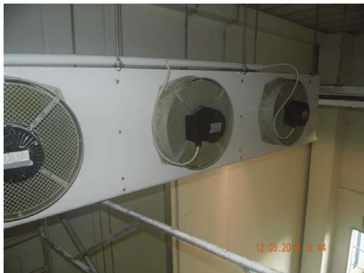
Foto 3: Verdampfer 9 – Wareneingang Frischdienst - nach der Hygiene-Reinigung
